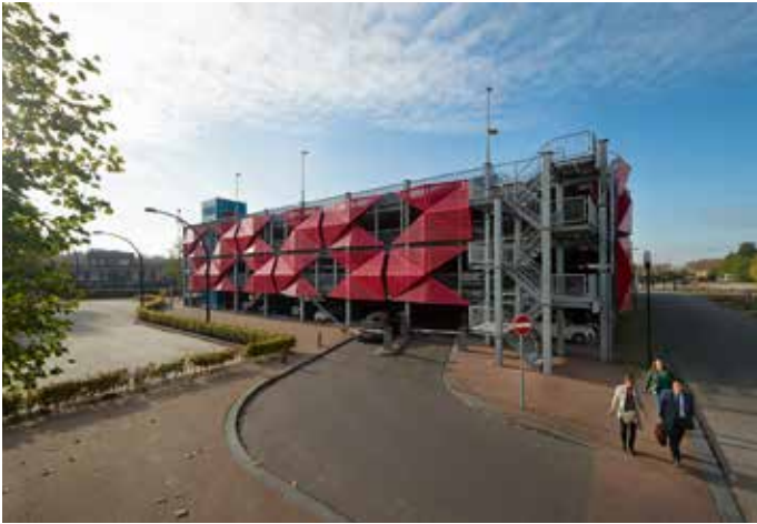
Beklede gevel in Almelo (boven) en groene gevel in Amersfoort (links).
